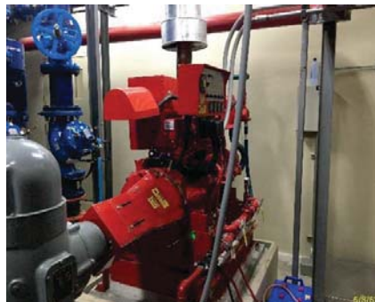
เครื่องสูบน้ำดับเพลิง
