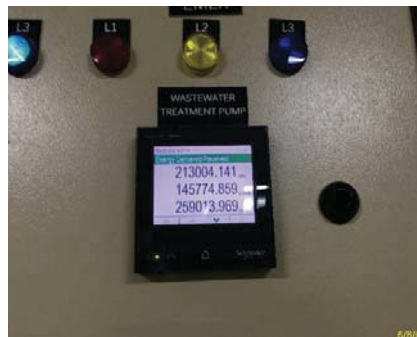
มิเตอร์ไฟฟ้าสำหรับระบบบำบัดน้ำเสีย
