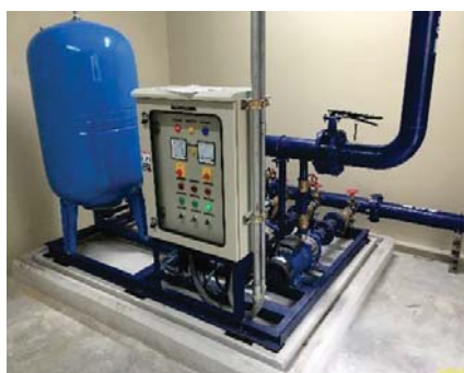
ปั๊มระบบถังอัดแรงดัน
