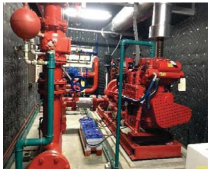
เครื่องสูบน้ำดับเพลิง
